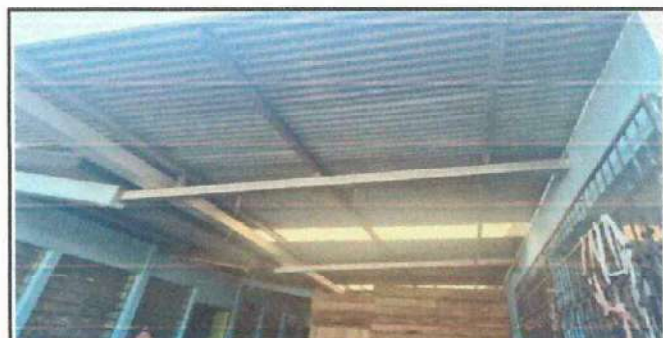
Foto 6: Cambio de lámina troquelada en el patio de la escuela
