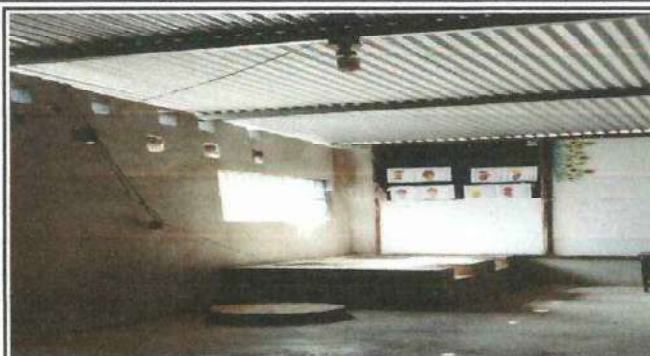
Foto 14: Colocación de campana y remodelación de polletón
