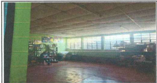
Foto 4: Cambio de lámina troquelada e instalación eléctrica en aulas
