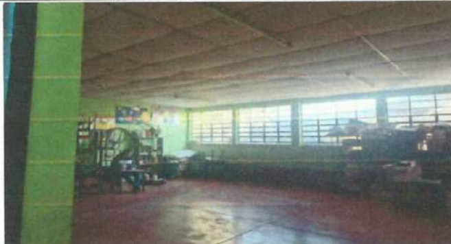
Foto 8: Sustitución de piso cerámico e instalación eléctrica
