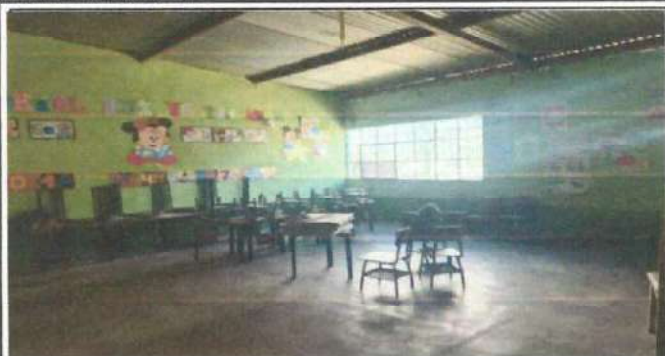
Foto7: Sustitución de piso cerámico e instalación eléctrica
