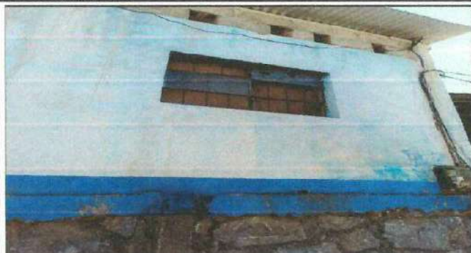
Foto 13: Remodelación en estructura de metal en ventana de la cocina
