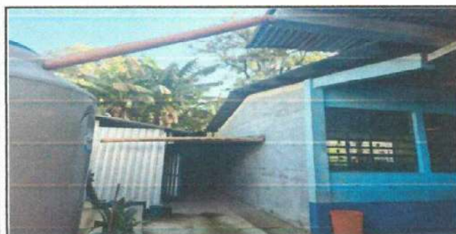
Foto 5: Cambio de lámina troquelada calibre 26, en el corredor y aula
