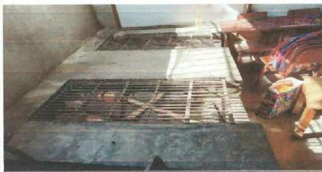
Foto 11: Remodelación de polletón y colocación de campana
