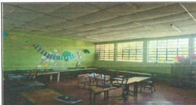
Foto 9: Sustitución de piso cerámico e instalación eléctrica
