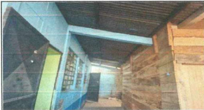
Foto1: Cambio de lámina troquelada Calibre 26
