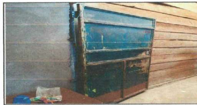
Foto 12: Mejoramiento de puerta de la cocina
